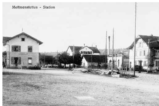
Bahnhof um 1923 - Die Gemeinde wird elektrifiziert. Bauarbeiten mit Holzstangenlager für den Bau der Elektrofneileitungen.
