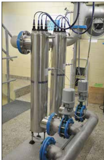
Die Entkeimungsanlage.
