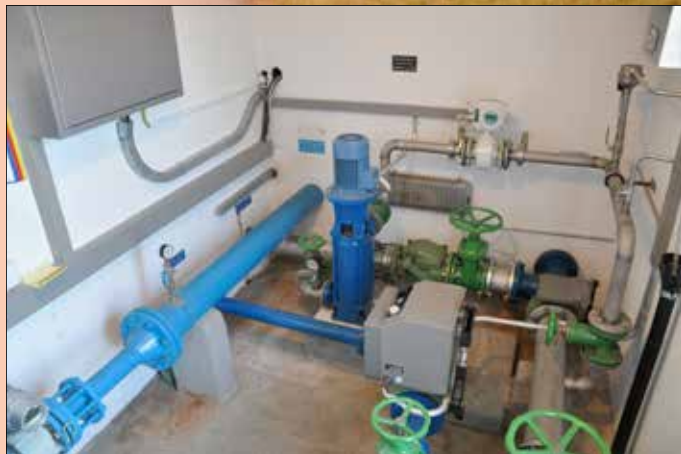
Blick in den Umstellschacht Grossholz.
