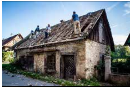
Das Waschhaus bei der Renovation im Herbst 2011.
