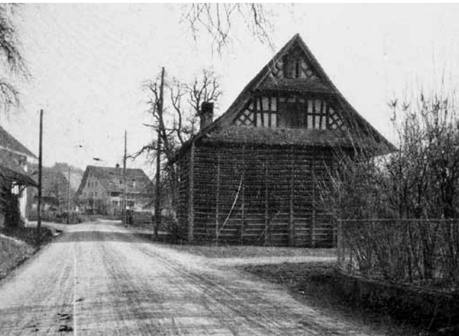
Das heutige Restaurant Spycher im ursprünglichen Zustand. Deutlich zu erkennen das Trocknungsgerüst. Bei der Renovation entfernt.
