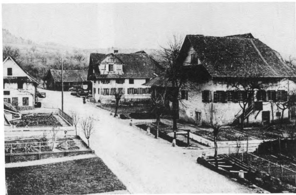
Längs der Albis- strasse fliesst der noch offene Dorfbach (mit Schwelli).
