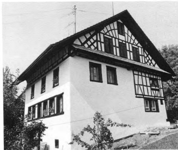
Die ehemalige Schenke Grossholzerstrasse 6.
