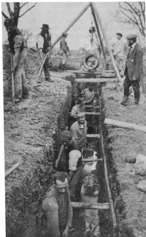
Grabarbeiten an einer Wasserleitung am Homberg um 1920.
