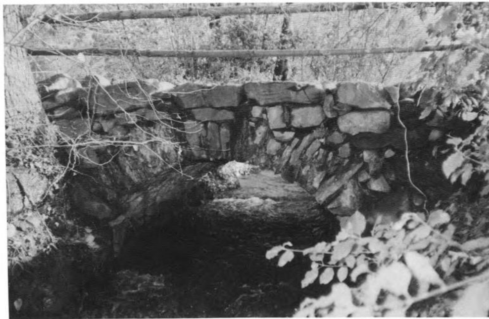
Die 1490 erwähnte Strasse Zürich-Luzern überquerte unterhalb von Wissenbach über diese Brücke den Haselbach.
