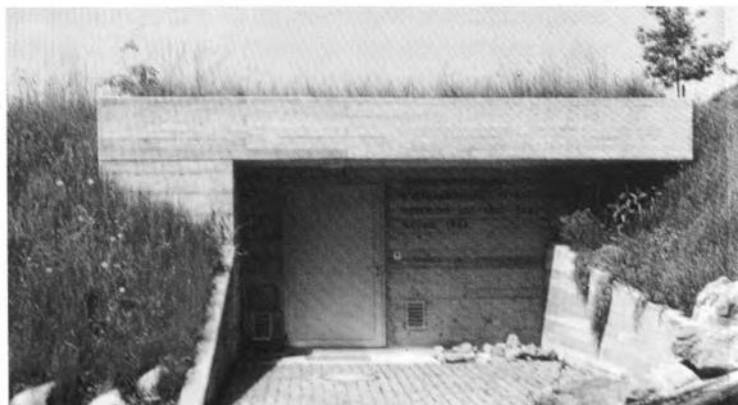
Das 1984 neu erbaute Reservoir im Loo.
