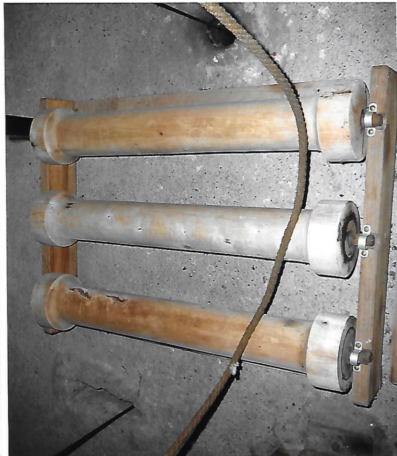
GLASFÜHRUNGEN UND ROLLEN FÜR GLOCKENSEILE
