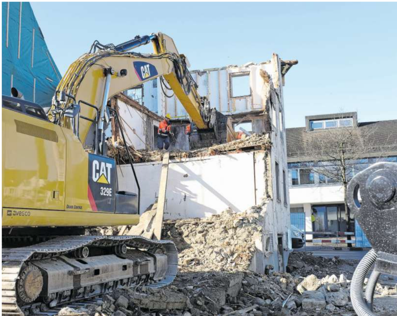
Vergangene Woche wurde die alte Sennerei im Bonstetter Dorfzentrum zurückgebaut. Im Hintergrund ist das Gemeindehaus zu sehen, links der denkmalgeschützte Teil der Liegenschaft Am Rainli 3, der nicht im Besitz der Sennhütte AG ist und stehenbleibt. (Bild Salomon Schneider)
